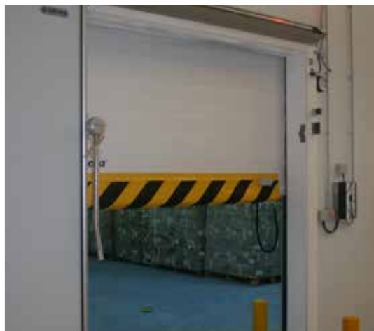
Combinación de puerta frigorífica corredera industrial y puerta rápida frigorífica.
